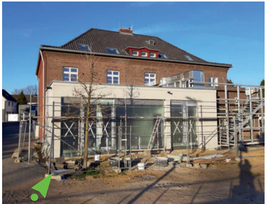
▲ Fast fertig und mit viel Platz für alle Gruppen: Gleis11. Foto: Eickhoff
