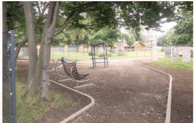
▲ Weg und Beete eingefasst, Zaun versetzt: im ersten Bauabschnitt ist schon viel geschafft. Foto: bb
